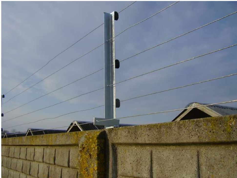
Ved betonhegn monteres 6 tråde
